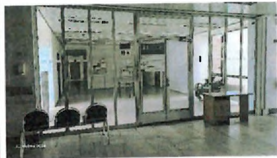
Nemovitost Radnice - vstup do kancelářských prostor
