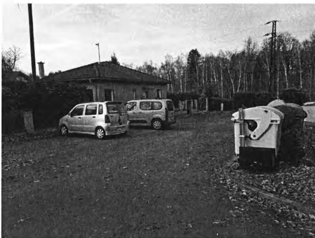
Část vozovky je na cizích pozemcích – nedostatečná šířka vozovky pro kolmé stání v případě prodeje pozemku a nedořešení majetkoprávních vztahů, kontejnery v rozhledovém poli řidiče
